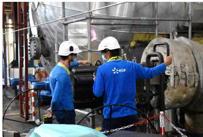
Chantier Groupe Sécheur-Surchauffeur
