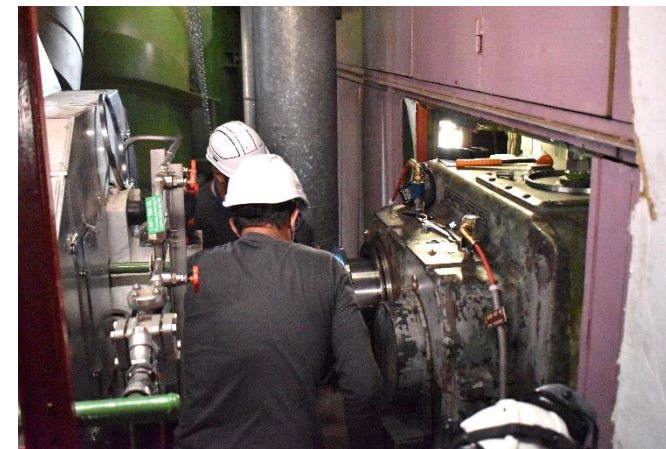
Chantier Phase 8 Transformateur Principal
