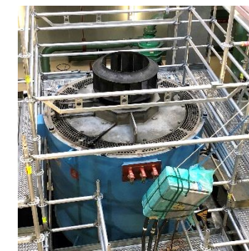
Chantier pompe CRF
