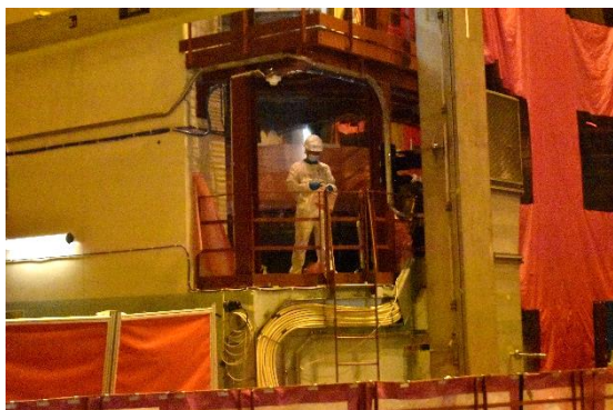
Préparation chargement combustible - BR
